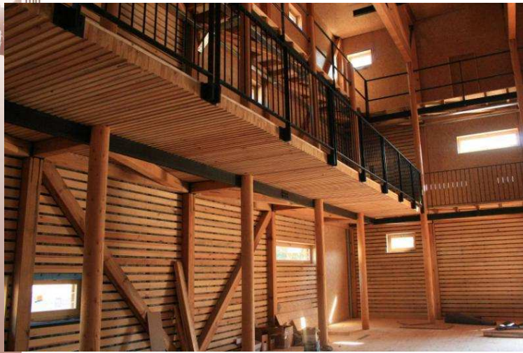
Plancher du type « planches clouées » en pin Laricio de Corse
